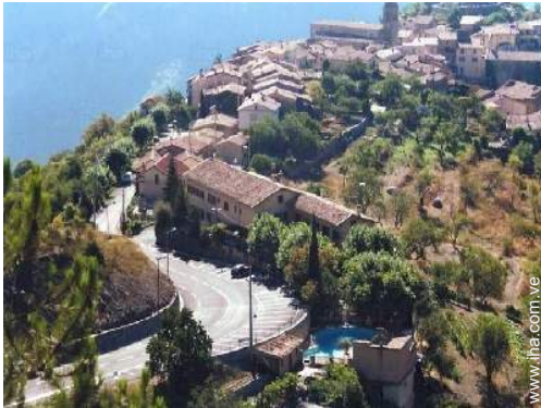
vista de conjunto
