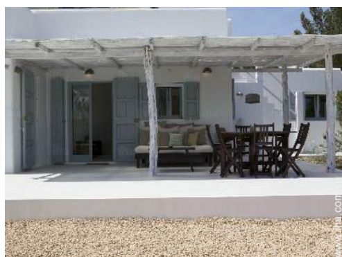
Confort interior e instalaciones
